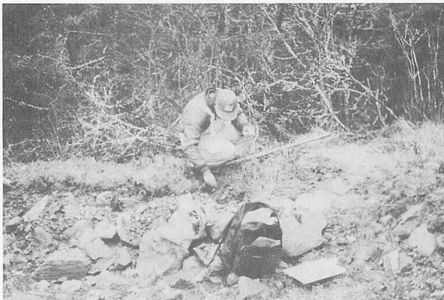
Planche 3. Mr. Stephen Powell examine les ruines d'un mur de pierre au sud-ouest de la Maison No. 2.
